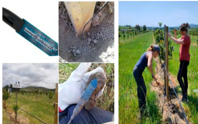
Fig. 4. Installazione della sensoristica per monitorare l'umidità del suolo.
