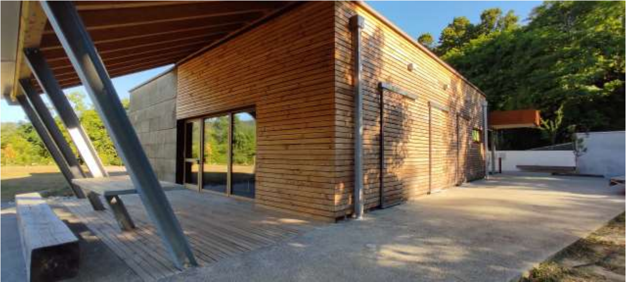
Il rivestimento esterno e il pavimento in doghe fugate di Douglasia, nonché gli elementi di arredo esterni in Douglasia protetti dalla tettoia SUD
