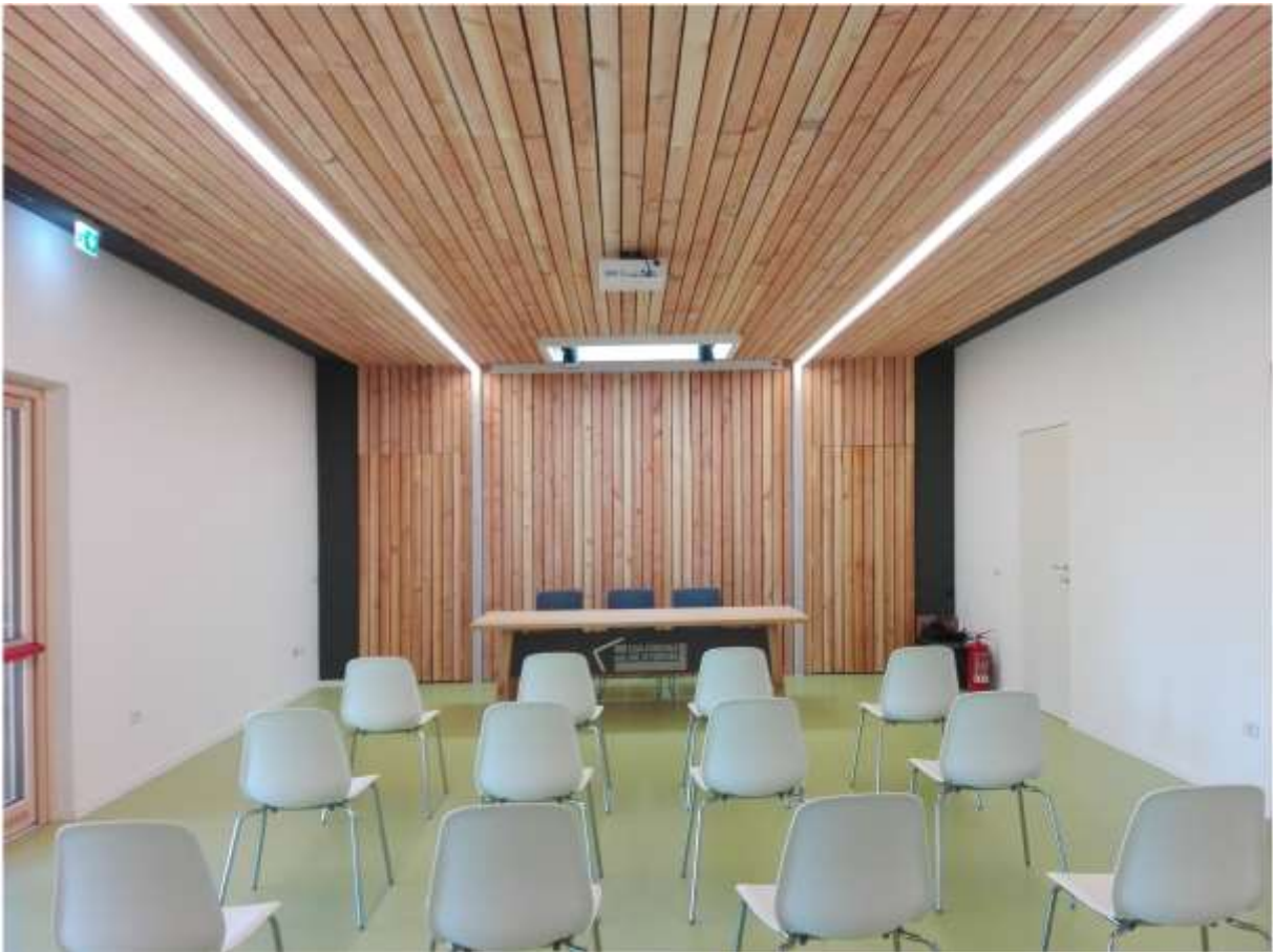
Rivestimento della sala polivalente in doghe fugate di Douglasia
