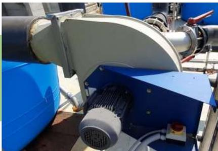
La **soffiante** genera un flusso d'aria in un circuito chiuso che collega reattori e scrubber. L'aria viene aspirata dai reattori e inviata allo scrubber, per poi rientrare nei reattori.
