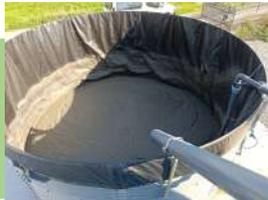
**Vasca** con capacità di 30 m<sup>3</sup> per ricevere gli effluenti da trattare nell'impianto provenienti da diversi allevamenti
