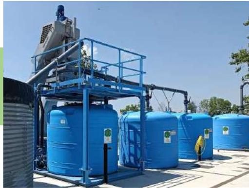
**Separatore a vite** elicoidale per rimuovere i solidi grossolani e facilitare il processo di rimozione dell'ammoniaca dall'effluente. **Tre serbatoi** da 7,5 m<sup>3</sup> raccolgono la frazione liquida, mentre la frazione solida viene raccolta in due cassoni.
