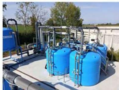
Il GO-ConservA prevede di utilizzare una tecnologia di strippaggio semplificato dell'azoto basata su un processo sperimentato in laboratorio con buoni risultati e che ha dimostrato di avere le caratteristiche adatte all'introduzione in aziende
