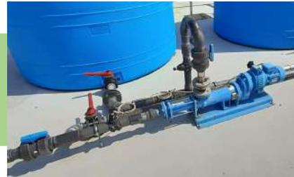
**Pompa monovite** da 4 kW per caricare la frazione liquida nei reattori di stripping e scaricare i reattori al termine del trattamento
